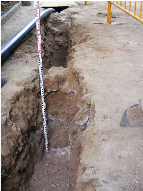
11. Tram 2. Localització del mur UE 08, de contenció o enjardinament.
