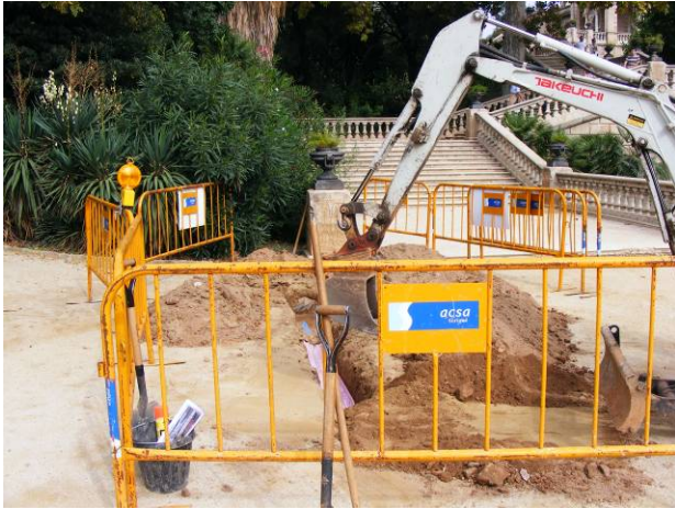
17. Tram 5. Obertura de rasa a la zona de la plaça
