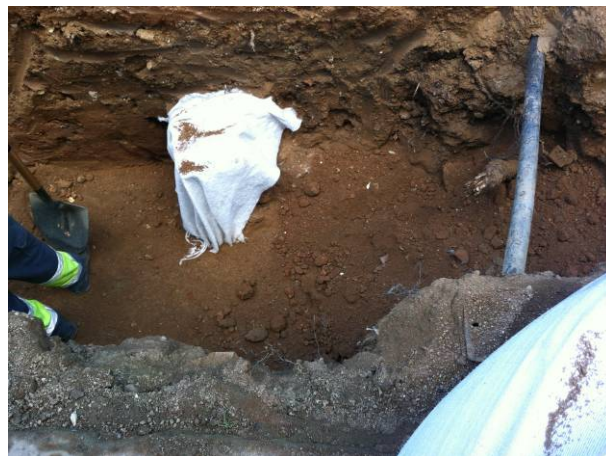
28. Cobriment mur UE 04. Tram nord.
