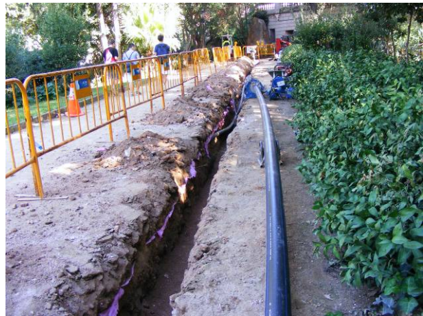
14. Tercer tram de rasa. Aquesta discorre paral·lela a un tub de reg.
