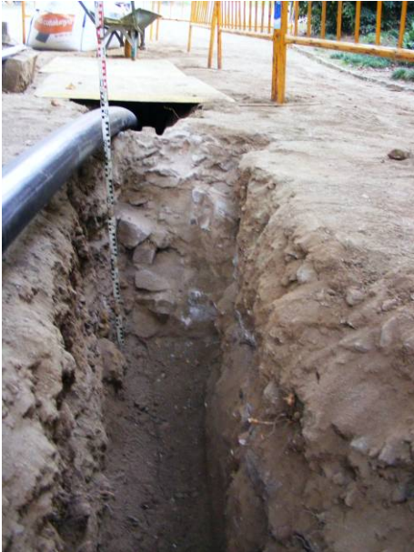
9. Tram 2 Localització del mur UE 07, de contenció o enjardinament.
