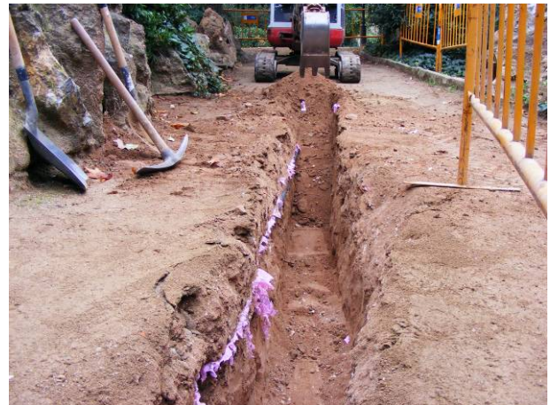
12. Tram 3 de rasa. Aquesta discorre paral·lela a un tub de reg.
