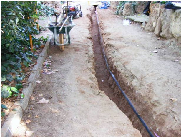
13. Tercer tram de rasa. Aquesta discorre paral·lela a un tub de reg.
