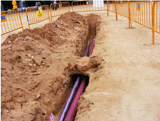
19. Tram 5. Col·locació de canonades. Arqueta arrasada UE 10
