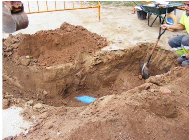
16. Tram 5 de rasa. Obertura de rasa a la zona de la plaça
